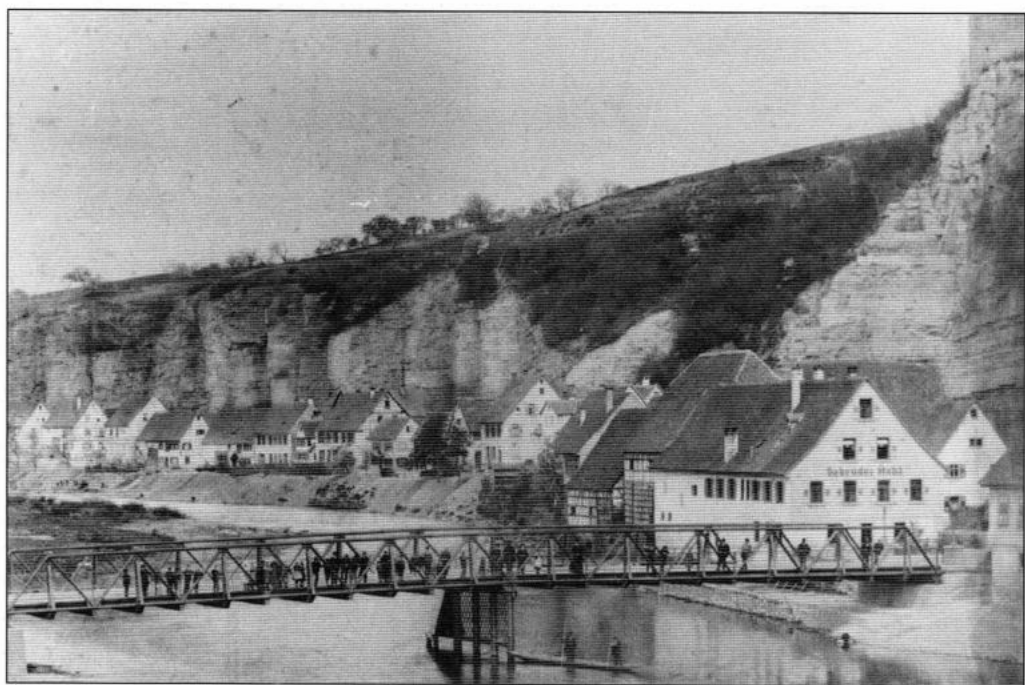
Die König-Wilhelm-Brücke wurde 1899 in Eisenkonstruktion erstellt. Bis dahin diente eine Holzbrücke als Übergang. Auf dem Burgrücken oberhalb der Häuserzeile der Enzstraße waren zu dieser Zeit noch Weinberge angelegt.
