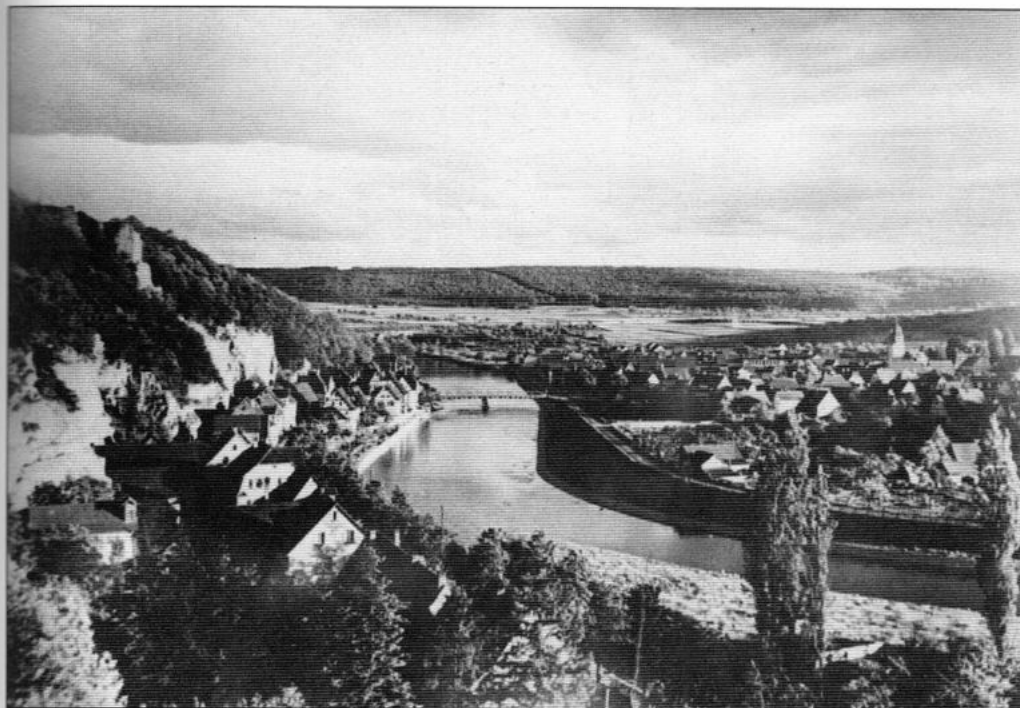
Der Blick vom Ulrichweg auf den neu angelegten Damweg zwischen dem Waldensersteg und der König-Wilhelm-Brücke.
