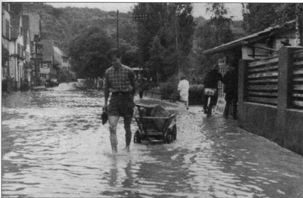
Trotz der Schutzmaßnahmen aus den 1930er-Jahren überfluteten immer wieder, wie hier im Juni 1955 in der Enzstraße, Unwetter die Stadt.
