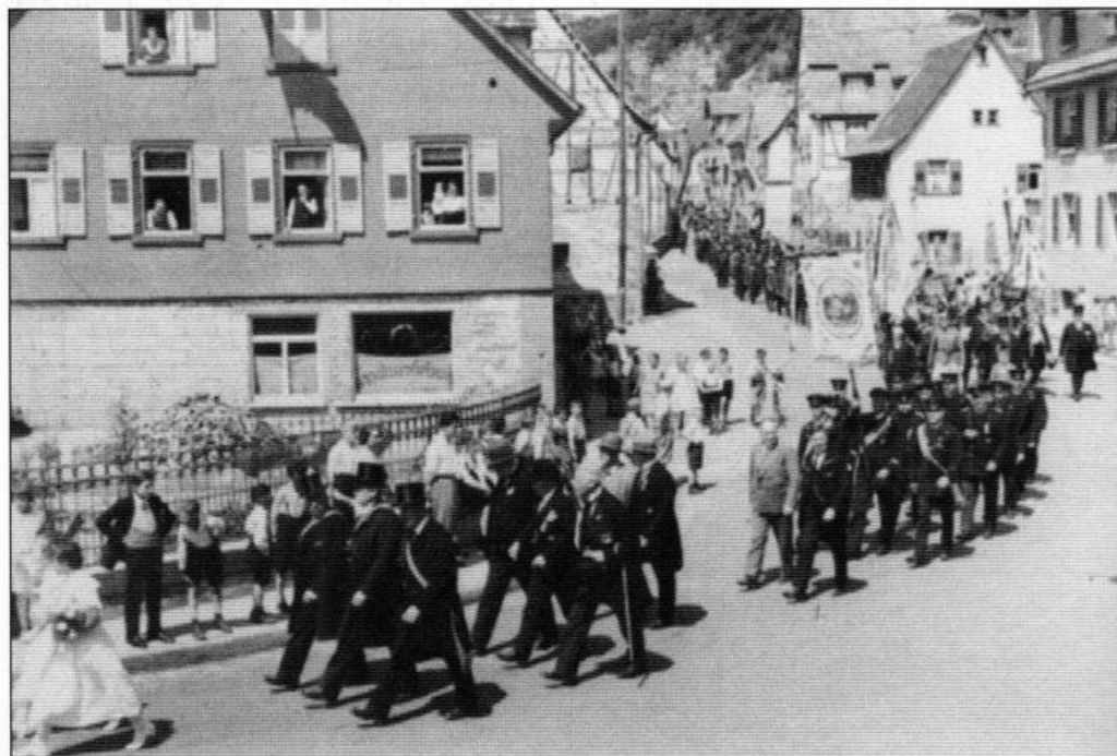
Der Festzug zum Heimattag 1931 führte von der Enzstraße über die König-Wilhelm-Brücke durch Dürrmenz und zurück zum Festplatz.
