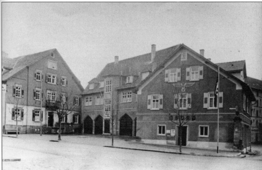
Das Rathaus und die Parteizentrale der NSDAP lagen um 1939 in unmittelbarer Nachbarschaft zueinander am heutigen Kelterplatz. Im Mittelgebäude war im ersten Obergeschoss die Sparkasse untergebracht. Im Erdgeschoss hatte die Freiwillige Feuerwehr ihre Löschfahrzeuge untergestellt.
