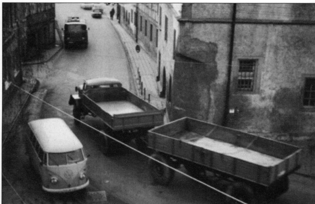
Besonders betroffen von der Zunahme des Kfz-Verkehrs war die innerstädtische Bundesstraße 10. Dabei erwies sich das „Keltreck“ in der Stuttgarter Straße als besonderer Gefahrenpunkt.
