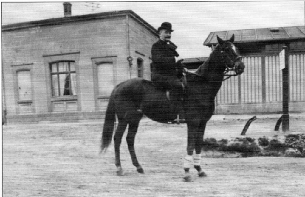
Um 1920 zeigt sich hier der Mühlenbesitzer Rudolf Bauer vor dem Bahnhof. Es war üblich, dass sich Bahnbenutzer mit der Kutsche oder dem Pferd zum Bahnhof begaben, um dann die Weiterreise auf dem Schienenweg fortzusetzen. Ihre Pferde wurden derweil durch Bahnbedienstete versorgt.
