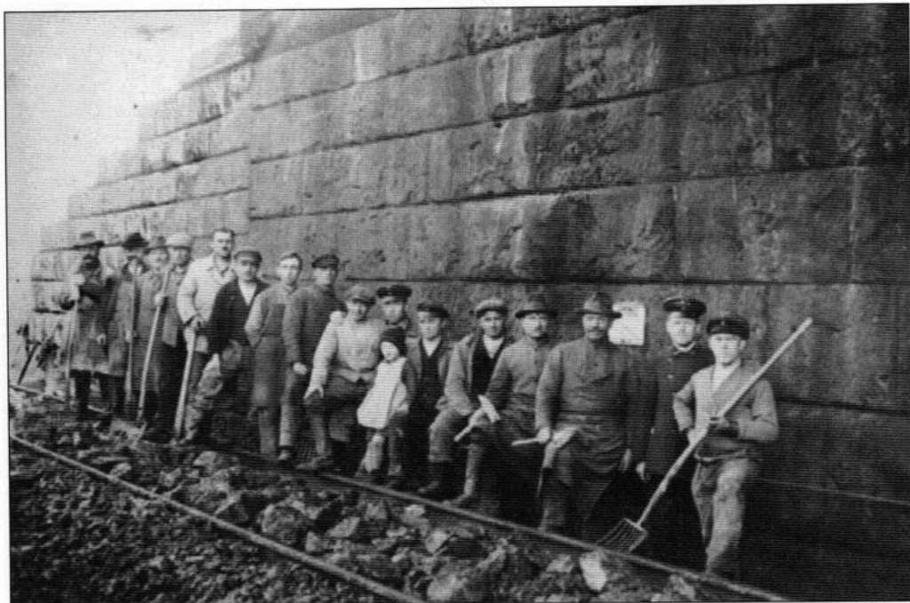
Zuständig für die Pflege und Instandhaltung der Gleisanlagen waren die Angehörigen des Gleisbauzuges Mühlacker mit ihrem Rottenführer Gotthilf Kärcher, der als Zweiter von rechts zu erkennen ist.
