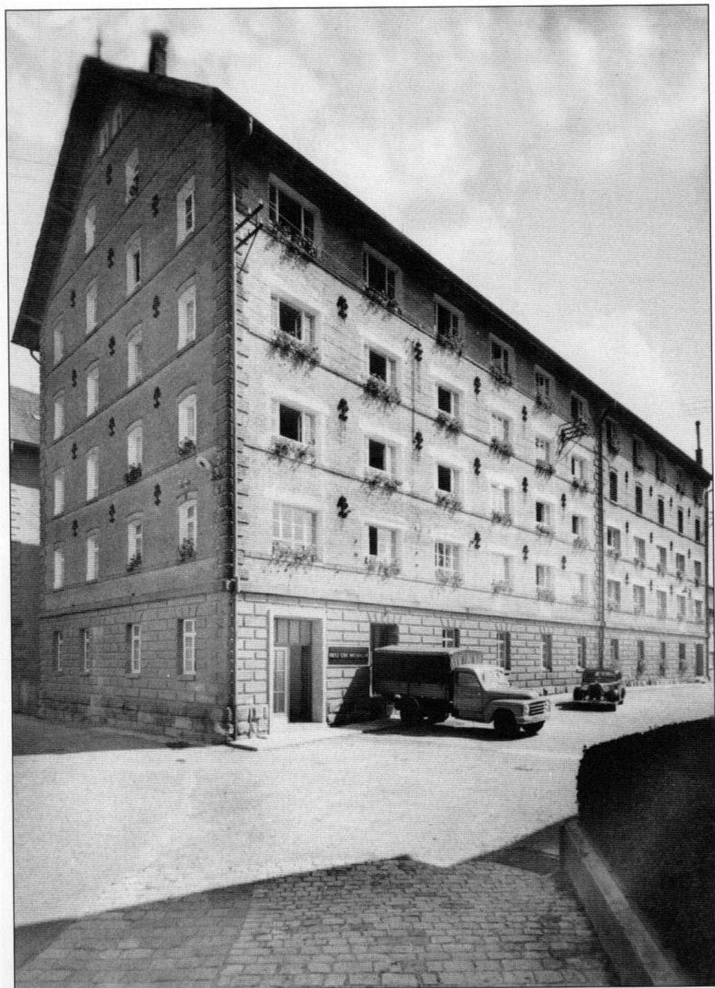
Nach der Stilllegung des Mühlebetriebes im Jahre 1925 nutzten verschiedene mittelständische Industriebetriebe die Gebäude des Mühlehofes. So hatten hier vor dem 1979 erfolgten Abriss Firmen wie Fakir, Otto Filitz (Metzler), Fritz Oskar Michallik und die landwirtschaftliche Verkaufsstelle ihren Sitz.
