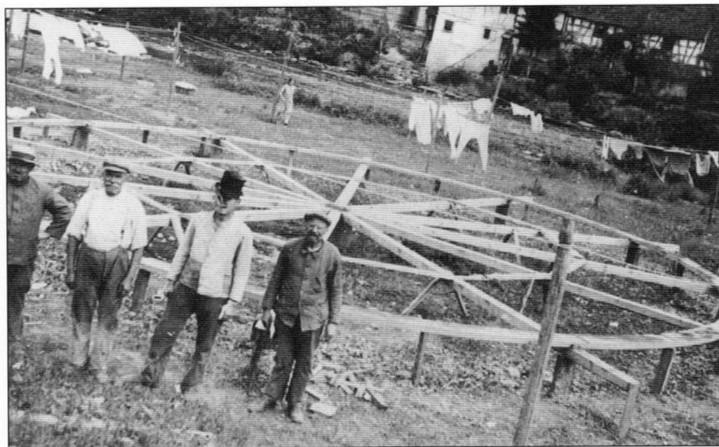
Ende der 1920er-Jahre wurde ein überschlächtiges Mühlrad durch die Zimmerei Beilharz auf dem Öhrlach abgezimmert. Von links sieht man den Schreiner Grau, den Mühlenbauer Wilhelm Albrecht sowie die Schreiner Gotthilf Beilharz und Gottlob Amos bei der Arbeit. Die alte Mühle und die Enz sind im Hintergrund zu erkennen.
