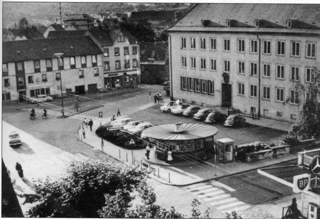
Seit etwa 1960 zeigte die neue Stadtplanung ihre ersten Auswirkungen. Auf dem Areal vor dem Finanzamt wurden die Gasthäuser „Sonne“ und „Ochsen“ abgerissen. Der neu erbaute Kiosk bestand bis in die 1970er-Jahre.
