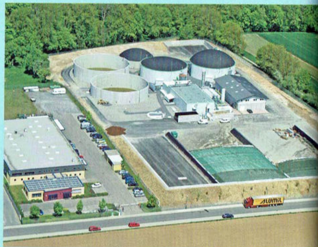
Haben immer die Nase vorn: Die Stadtwerke Mühlacker betreiben im Industriegebiet „In den Waldäckern“ eine Biomethananlage, welche zu den modernsten Deutschlands zählt.
