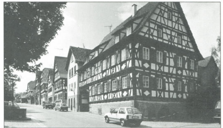
Obere Knittlinger Straße, Haus Nr. 12, erbaut 1781
