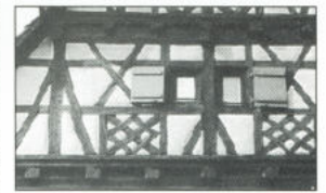
Kennzeichnend für 16. u. 17. Jh.: Bundständer als "Fränkischer Mann"; Rauten- und Andreaskreuzausfachungen
