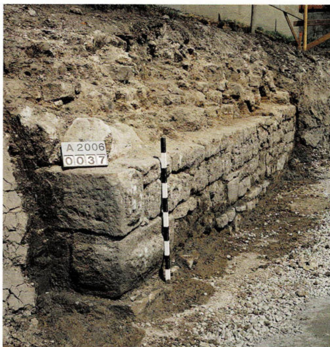
Abb. 207 Rottenburg a. N.- Wurmlingen. Blick von Südosten auf die freigelegte Mauer in der Hirschauerstraße. Im Vordergrund die Gebäudeecke mit Buckelquadern aus Stubensandstein.
