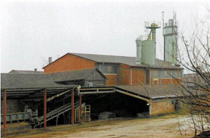
Beschickerhalle und Tonaufbereitung (7, 10, siehe Seite 3)
