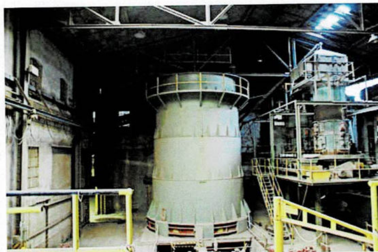
Tonsilo, alte Mauerziegelanlage (11, siehe Seite 3)
