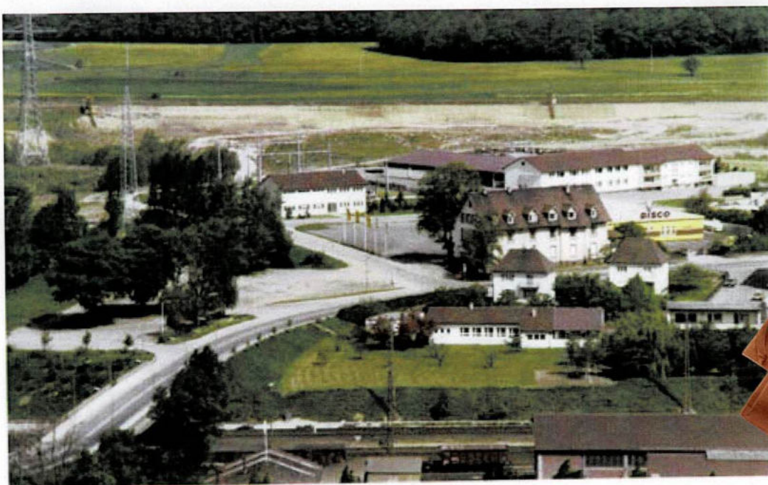
Jakobshöhe, Gesamtansicht der Kreuzung nach Abriss der Gaststätte
