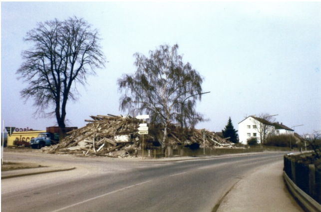
Was vom alten Verwaltungsgebäude übrig blieb Quelle: K. Kierstein (2)
