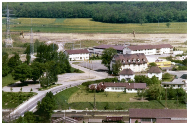
Jakobshöhe, Gesamtansicht der Kreuzung nach Abriss der Gaststätte
