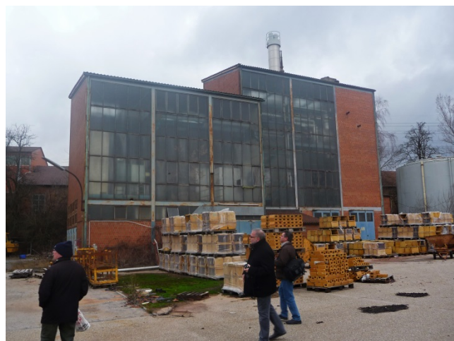
ehem. Maschinenhaus bzw. Kraftzentrale (2)
