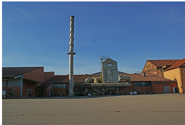
Rauchgasreinigungsanlage (28)
