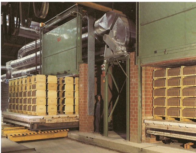
Kassettenbestückte Ofenwagen werden den Tunnelöfen zugeführt Quelle: Stadtarchiv Mühlacker
