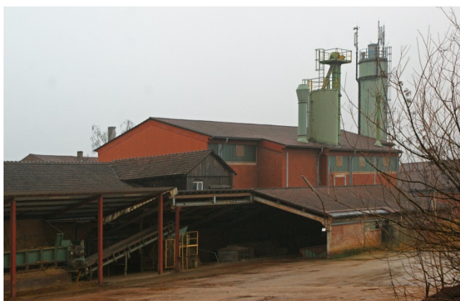
Beschickerhalle und Tonaufbereitung (7, 10)
