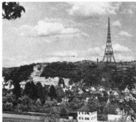
Großsender 192 m hoch, höchstes Holzbauwerk der Welt
