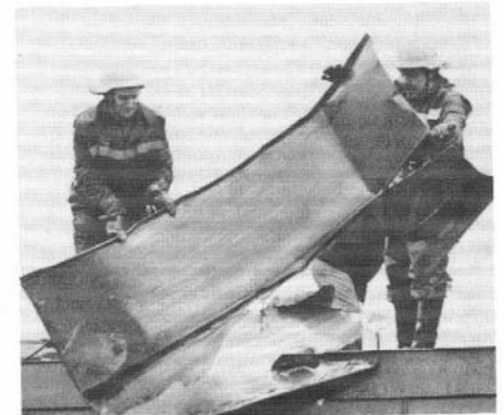
Die Kupferverkleidung wird abgenommen
