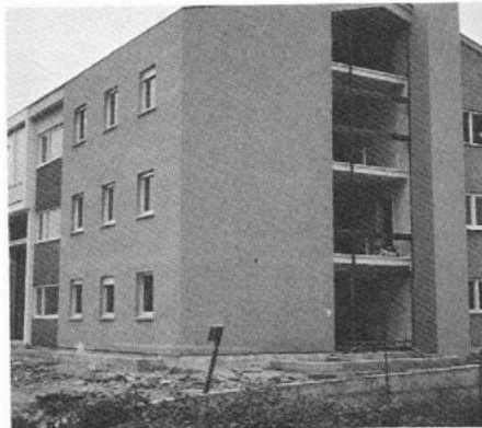
Feuerwache im Bau
