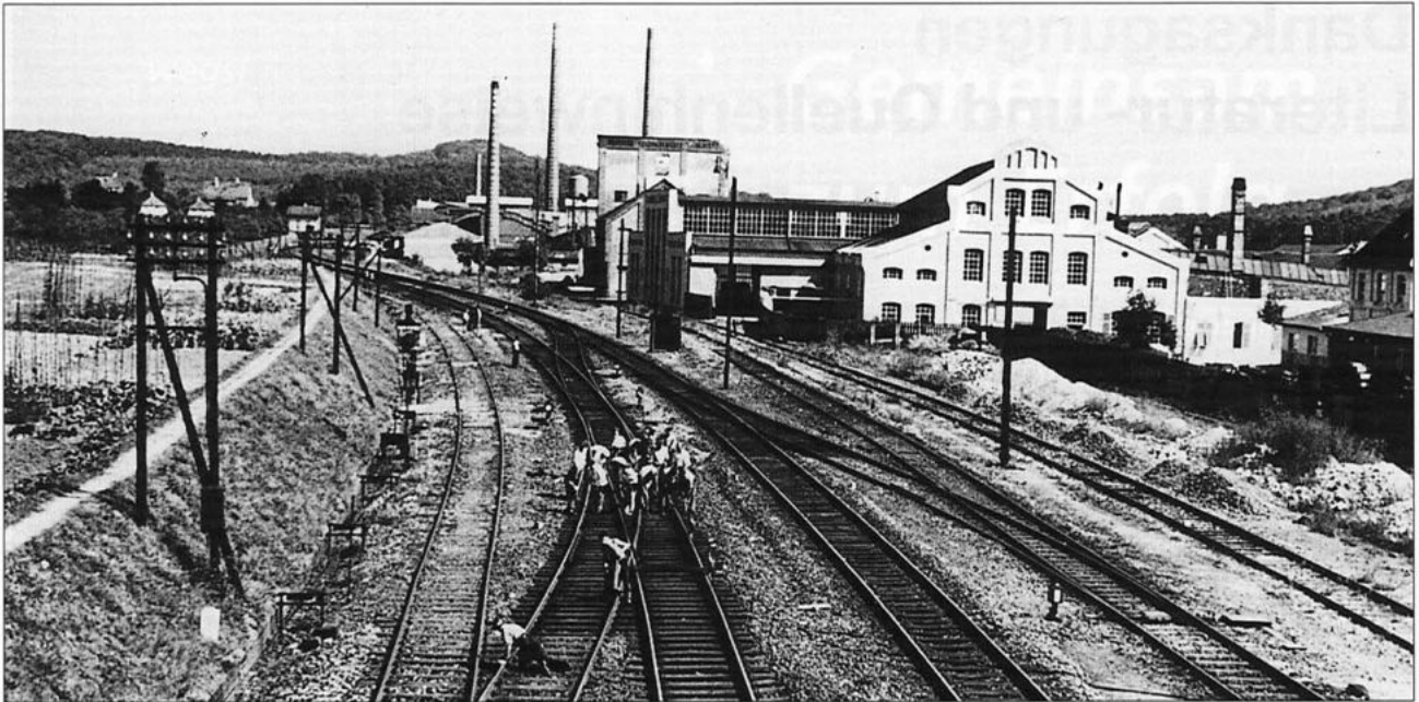
Gleisbauarbeiten 1949, im Hintergrund die Firmen Händle und Steuler (Landesbildstelle Württemberg)
