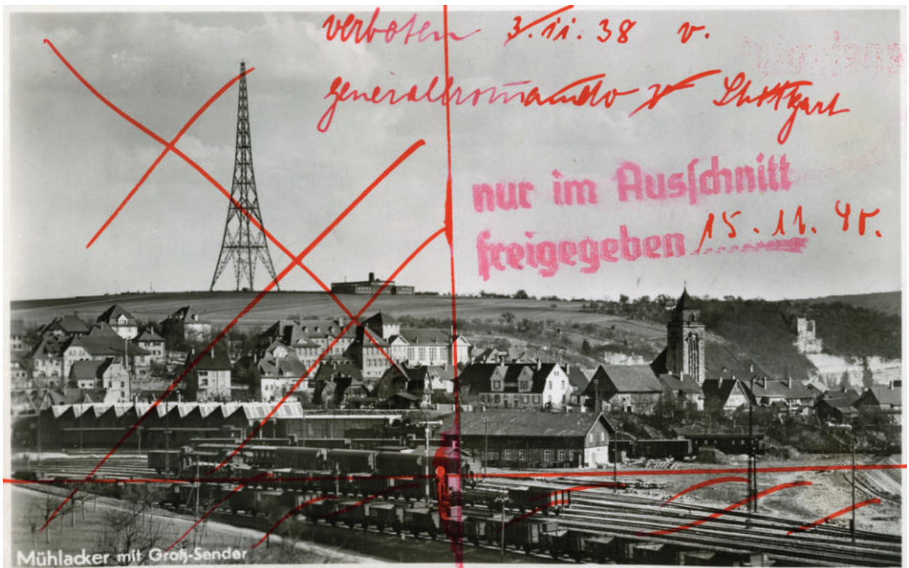
Die Postkarte stammt dem Musterbuch des Verlags Gebrüder Metz GmbH & Co. in Tübingen. Das Motiv mit dem 1934 errichteten neuen Sendemasten und dem Bahnhof Mühlacker im Vordergrund wurde 1940 nur ausschnittsweise freigegeben, nachdem es noch zwei Jahre zuvor ganz verboten worden war. Sammlung Stadtarchiv Mühlacker/Haus der Geschichte, Stuttgart
